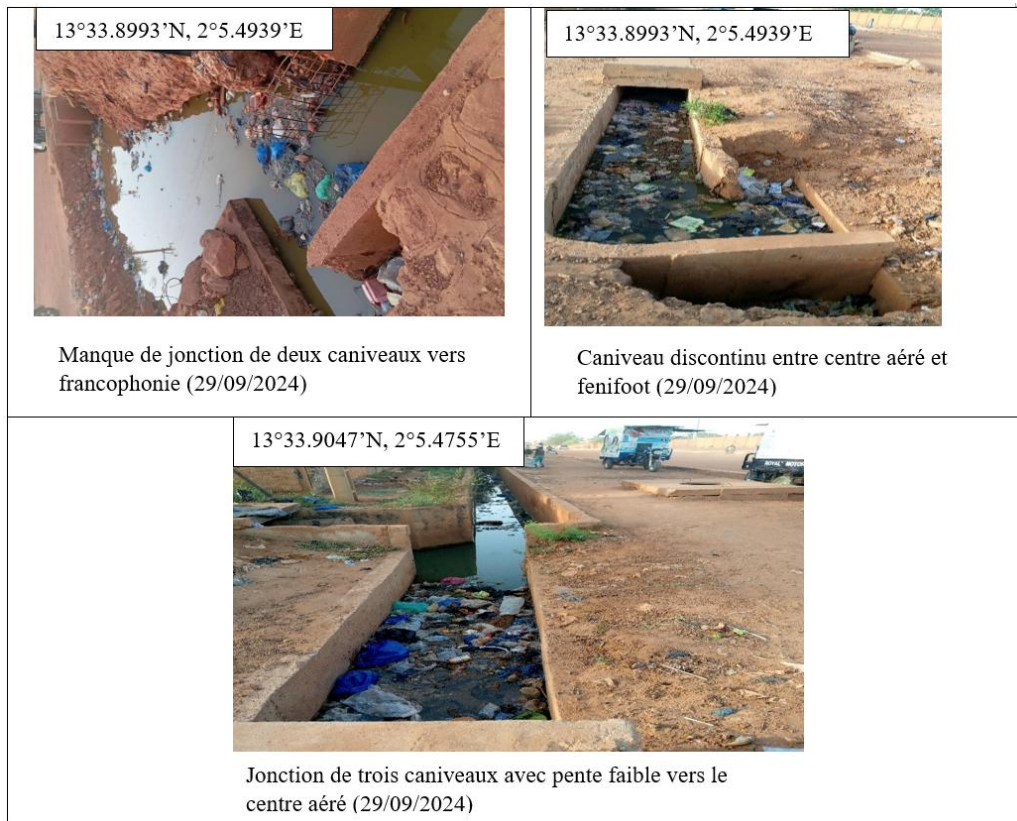
Figure 10 : Quelques défauts de conception retrouvée sur le terrain
