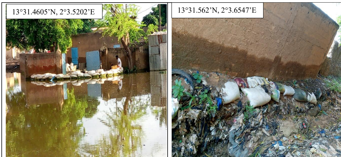
Figure 13 : Utilisation des sacs de sable comme technique anti-inondation
