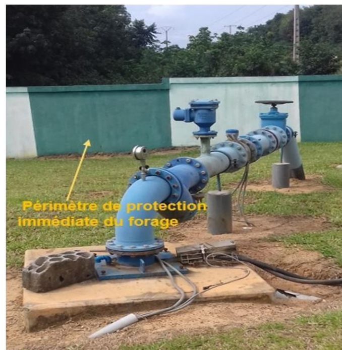
Figure 5 : Périmètre de protection immédiate d'un forage à Songon
