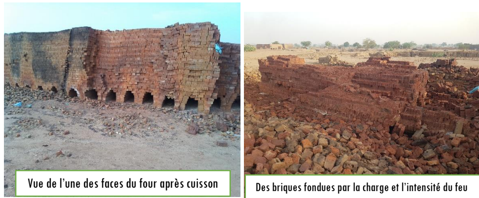
Figure 4 : Vues de quelques étapes de construction de four et de cuisson des briques
